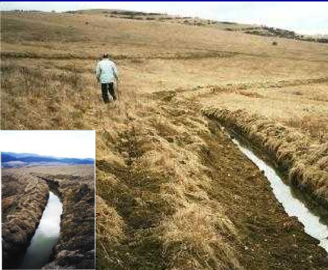
Vrstevnicové vodoholdingy a prútené koše Torysa 1997
