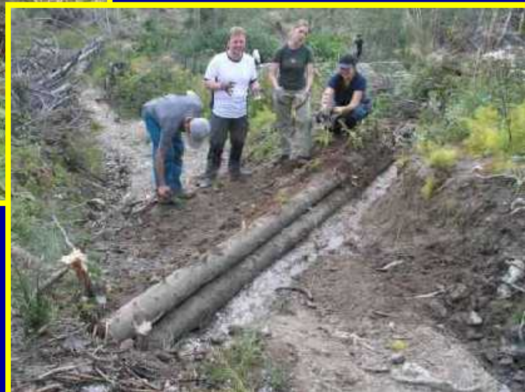
Budovanie hrádzi a odrážok na svážniciach (2007)
