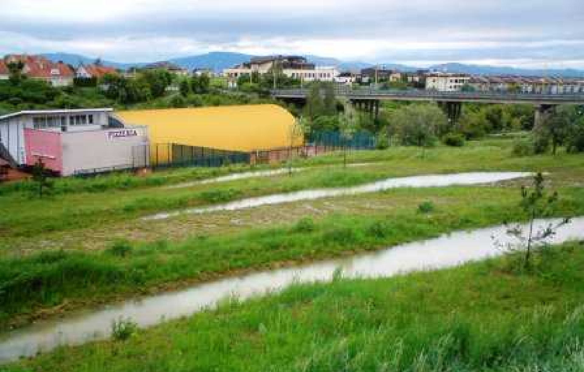
Svahové priekopy na zbieranie dažďovej vody
