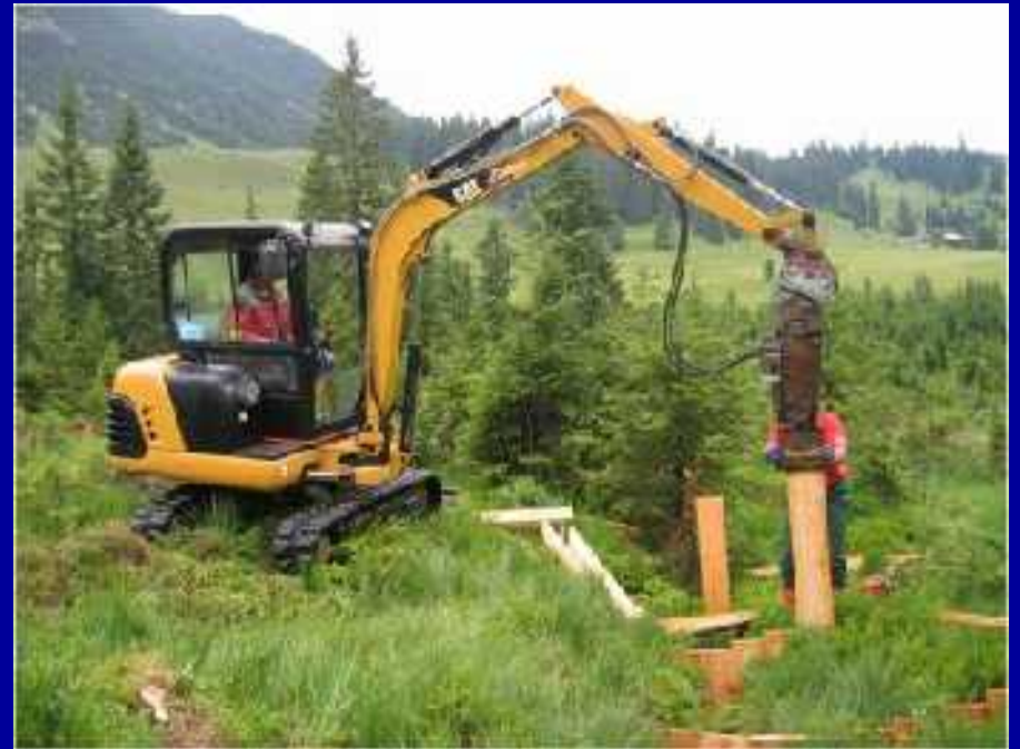
In schweißtreibender, händischer Arbeit wurden über 70 Dämme in den zähen Moorboden geschlagen
